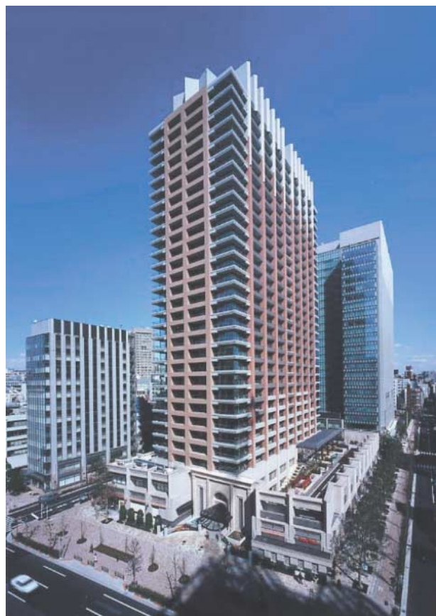
写真-1 東京パークタワー外観
