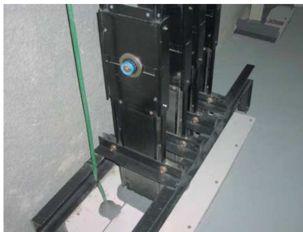
写真-3 床貫通部
