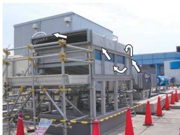
写真-1 トンネル実ガス実験の概観
