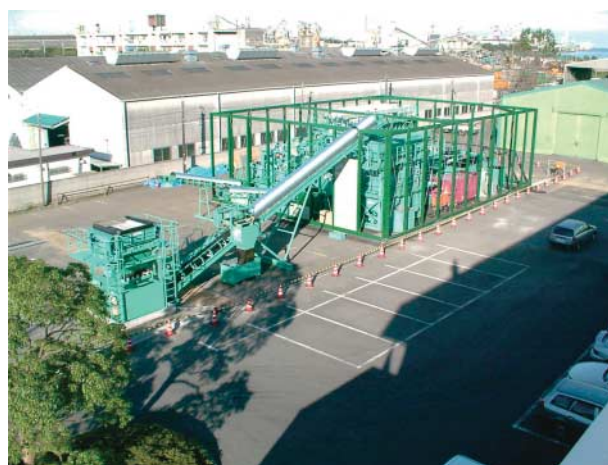
写真-1 土壌洗浄プラント全景（防音壁取付前）
