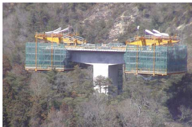
写真-1 張出し施工状況
