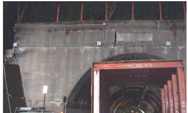
写真-4 新潟側坑門壁変状状況
