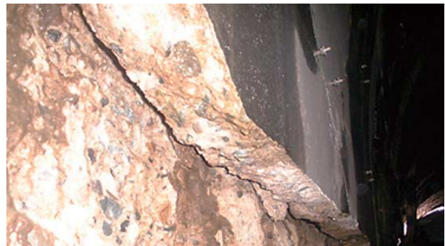
写真-3 側壁下部コンクリート剥落
