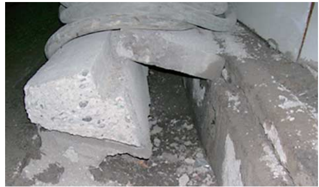
写真-1 山側側溝の変状
