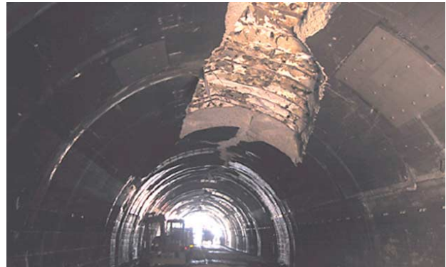
写真-2 天端部覆工コンクリートの剥落
