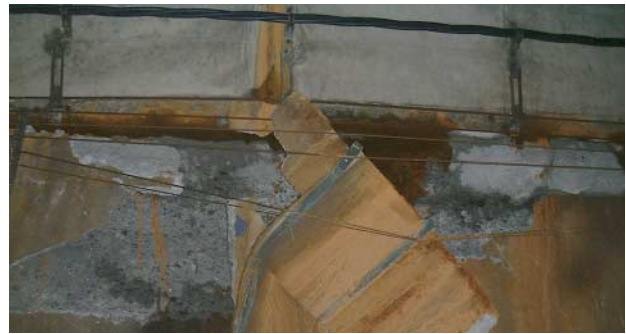
写真-2 せめ部破壊状況（東京方坑口より 605m 川側）
