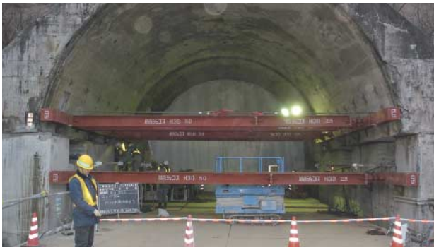
写真-4 アーチ移動完了状況
