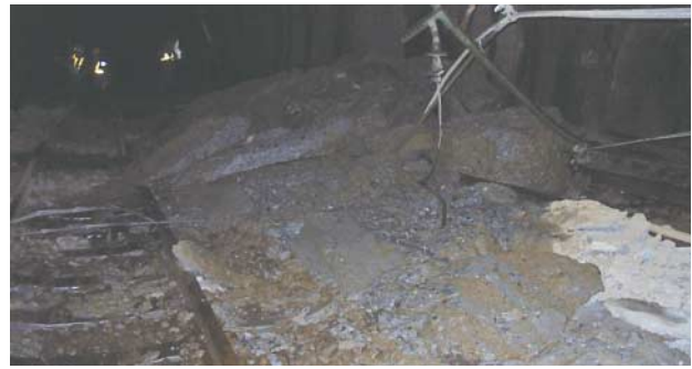
写真-1 覆工コンクリート崩落状況（東京方坑口より 525m）
