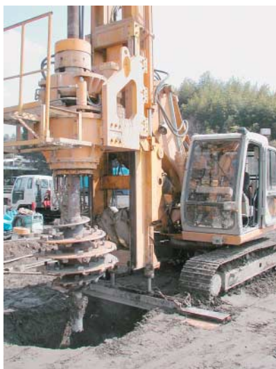
写真-1 施工機械とビット
