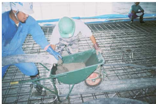
写真-3 先送りモルタルの回収状況
