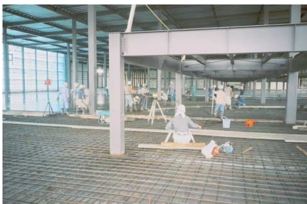
写真-4 コンクリートの天端レベル確認状況
