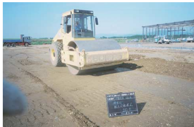
写真-1 転圧機械の施工状況
