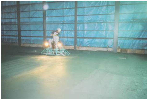
写真-8 騎乗式機械鋺による施工状況
