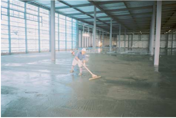
写真-6 浮き水の除去状況
