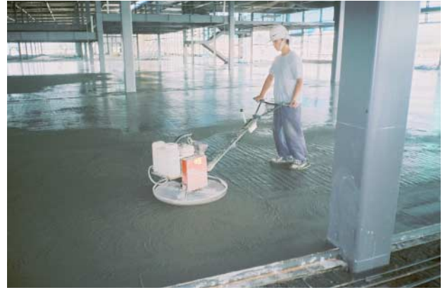
写真-7 円盤ずりによるノロ出し状況
