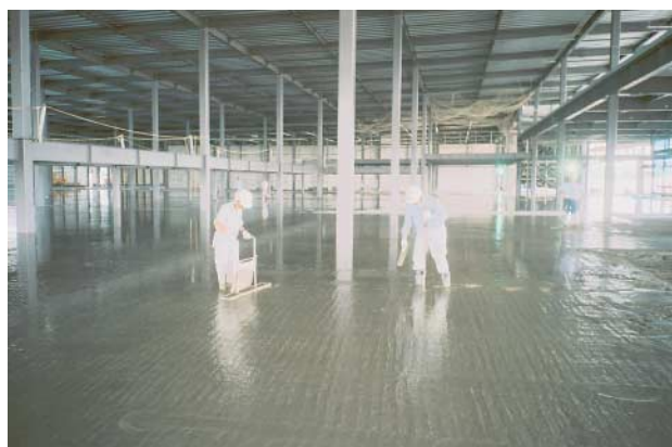
写真-5 タッピングおよびレベルの再測定状況
