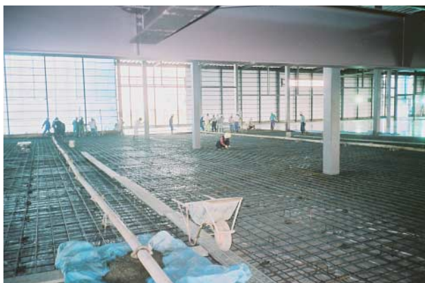
写真-2 配管状況
