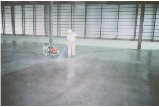
写真-9 浸透性表面硬化剤の施工状況
