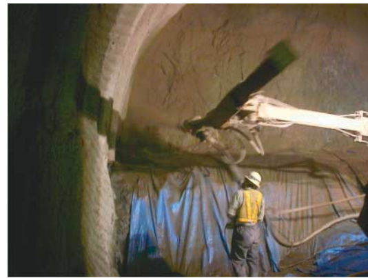
写真-1 吹付けコンクリート施工状況
