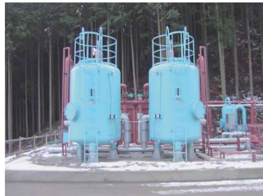
写真一2 砂ろ過濁水処理設備全景(工事開始時)
