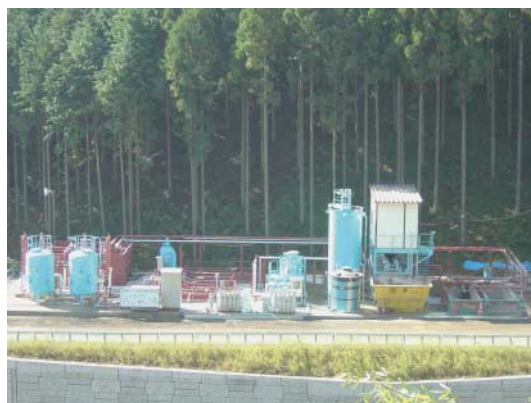
写真-1 濁水処理設備全景 (工事開始時)
