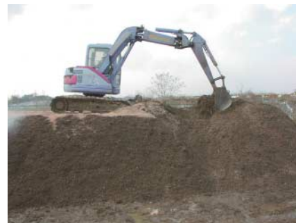
写真-3 副資材添加状況
