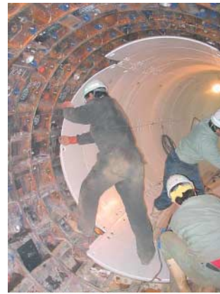
写真-3 レコパネル (R=15m) 組立状況
