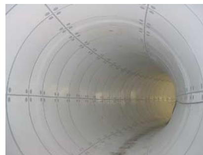
写真-5 レコパネルによる曲線区間 (R=15m) 仕上がり状況
