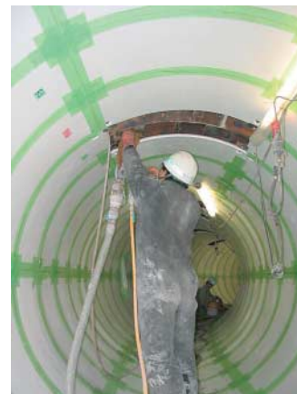
写真-4 中詰め充填材注入 (側面部)
