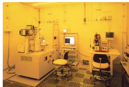
写真-1 クリーンルームの内部状況（クラス 100）
