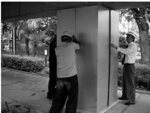
写真一七 鋼板取り付け
