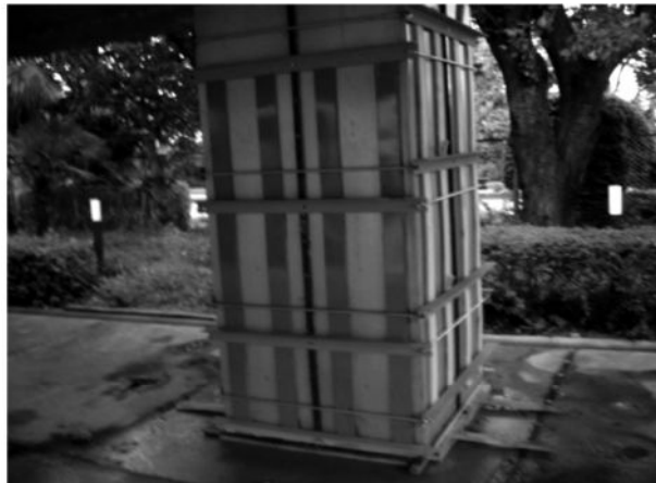
写真一六 押さえ金物の取り付け
