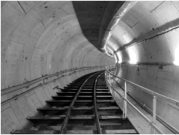
写真-6 坑内全景 (R=110 m)
