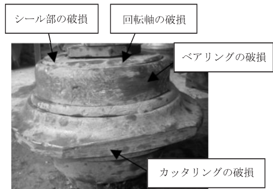
写真-8 No.4 カッタ破損状況
