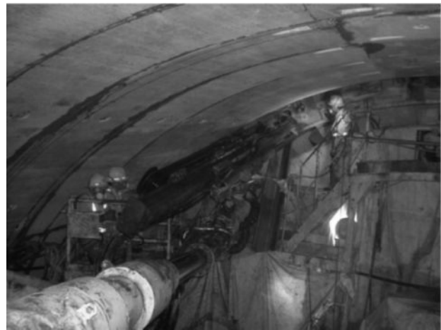
写真—3 AGF 施工状況
