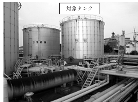
写真二 対象タンク周辺の隣接タンク、配管状況
