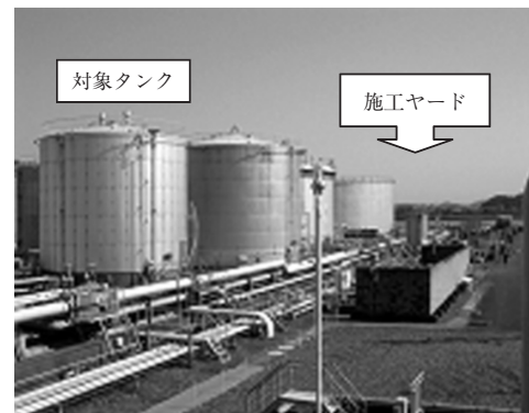
写真一 工事全景
