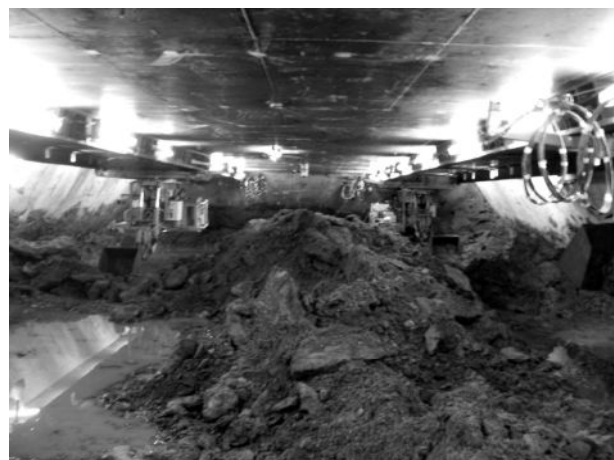
写真二1 函内無人化掘削状況
