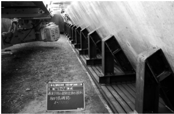
写真-4 過沈下防止金物使用時の函内状況
