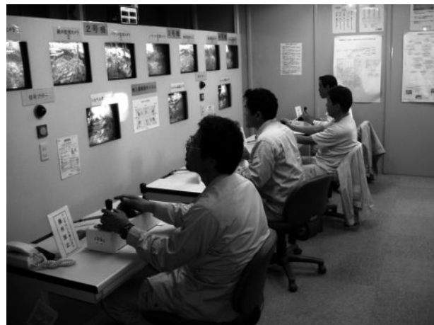
写真一1 遠隔操作による函内無人化掘削
