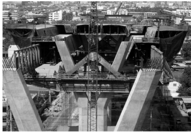
写真一2 サポートタイプの大型移動支保工 (橋脚ブラケット支持形式)
