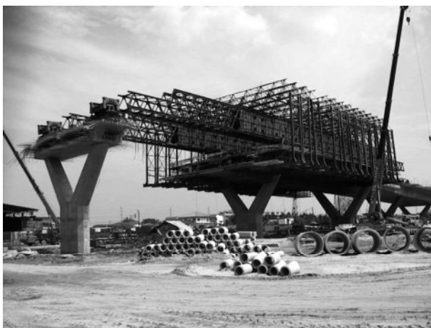
写真-4 ハンガータイプの大型移動支保工
