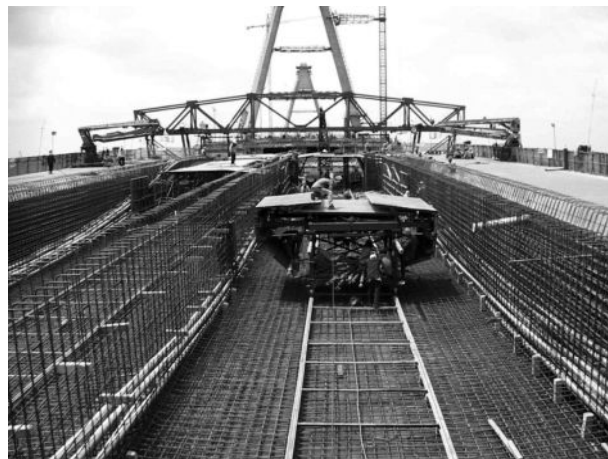
写真-5 移動式内型枠
