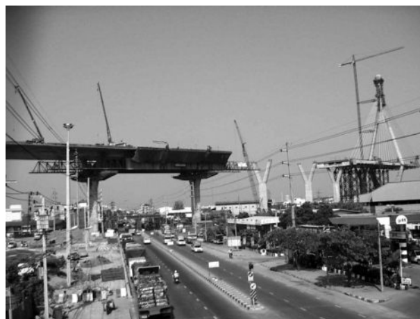
写真-1 大型移動支保工
