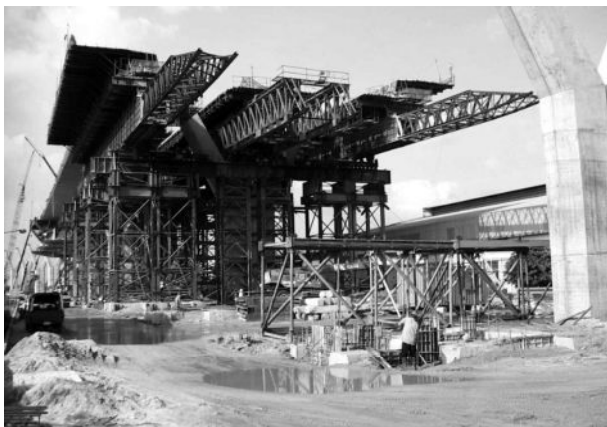
写真-3 サポートタイプの大型移動支保工 (タワーサポート支持形式)
