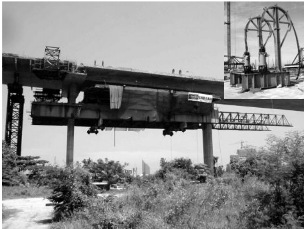
写真—6 一括吊り下げ解体
