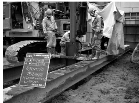
写真—3 芯材建込み状況
