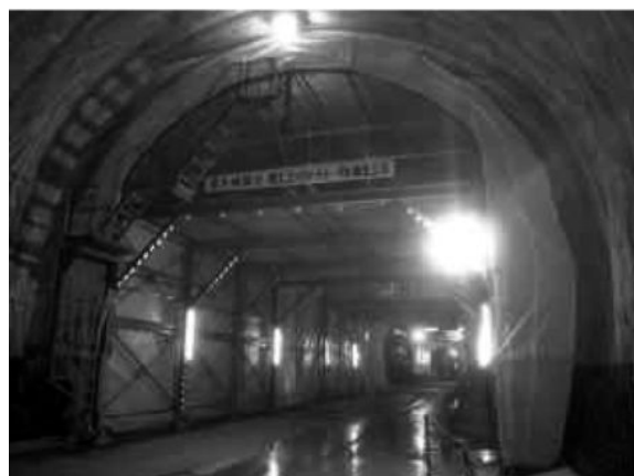
写真-1 後方より見た覆工コンクリート養生台車
