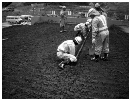
写真-1 ガイドパイプ設置状況
