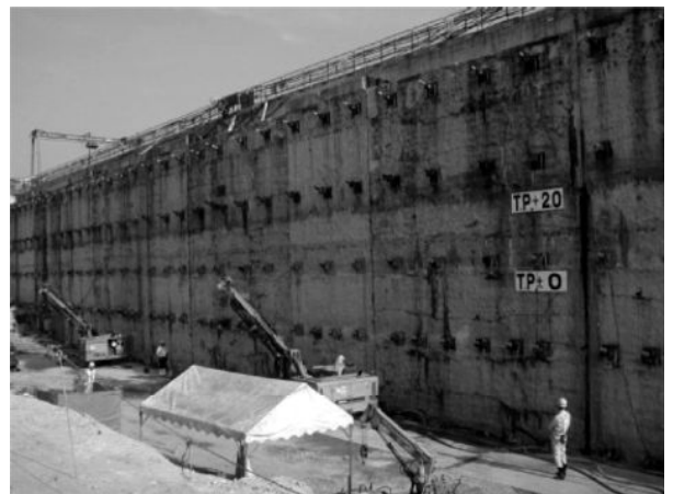
写真二 アンカー施工状況
