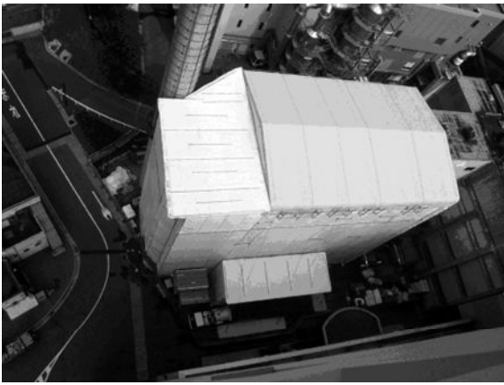
写真一2 飛散防止施設全景
