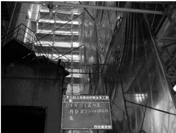
写真一3 内部解体状況
