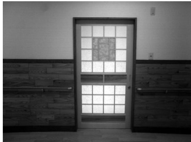
写真二 構造用合板使用箇所 (建具枠・腰壁見切り・巾木)
