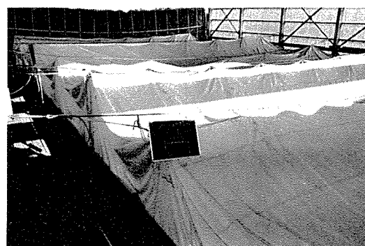
写真-5 養生シート
