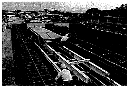
写真-4 移動中の中型枠
