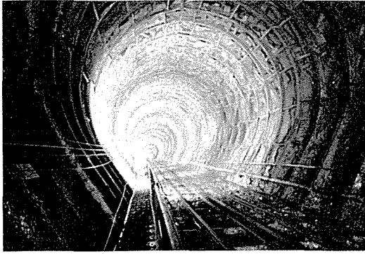
写真-6 支保工建込み状況
