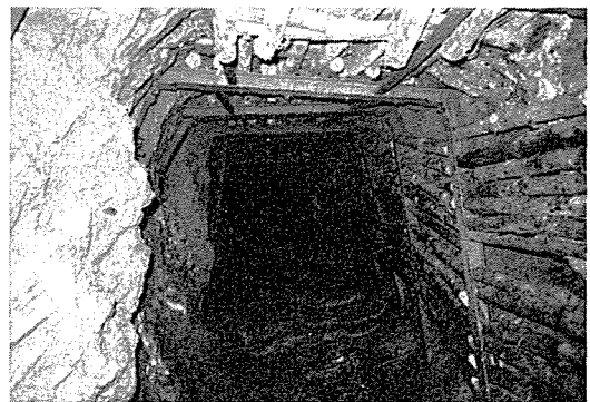
写真-3 導坑支保工
