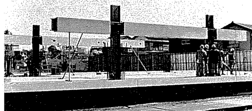
写真-3 ラーメン材建入れ調整
