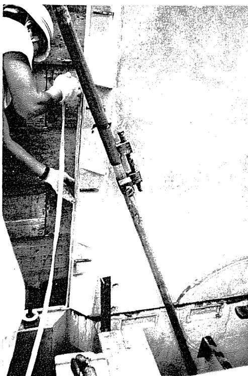
写真-2 コンプリフォームの施工
