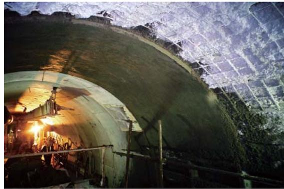
写真一十 吹付け仕上り状況
