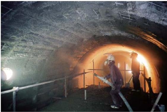
写真一八 吹付け施工状況
