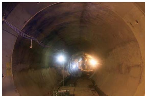
写真一十一 吹付け施工完成状況
