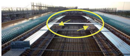
写真—5 床版緊張用突起型枠
