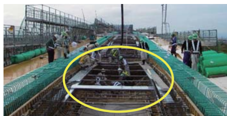
写真—6 下床版支承部の閉塞型枠
