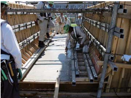
写真－3 仕上がり状況
