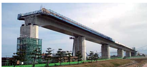
写真—7 5径間連続箱桁橋の完成状況
