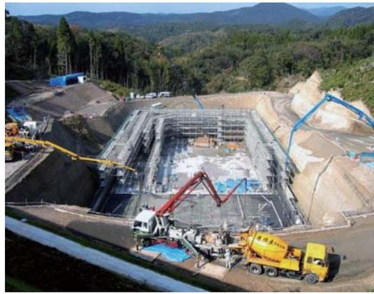
写真-2 貯留槽打設状況
