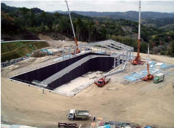
写真一四 鉄骨屋根設置状況
