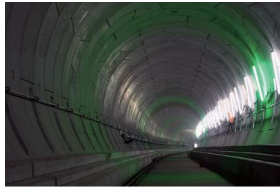
写真-7 復路 (A 線) 坑内全景
