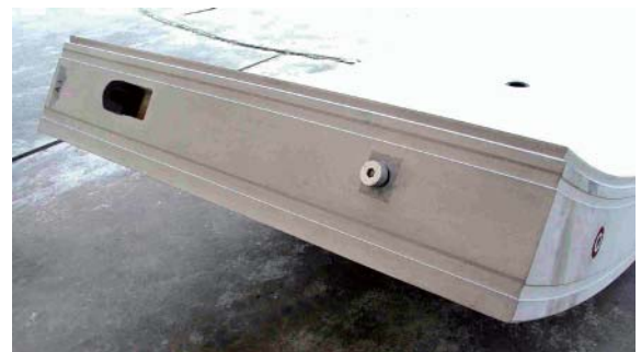
写真-4 A～Aセグメント間継手面
