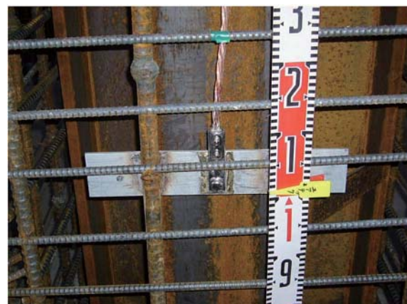
写真一3 鉄筋引出金物の溶接
