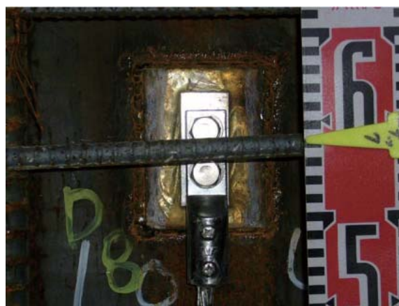
写真一2 鉄骨引出金物の溶接
