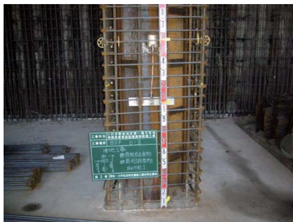
写真一1 柱基礎と鉄骨柱の接続
