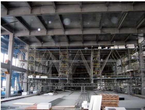
写真一6 A棟移動足場
