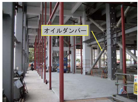
写真-9 オイルダンパー取付状況
