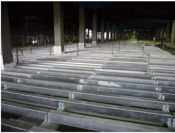
写真一5 根太施工状況
