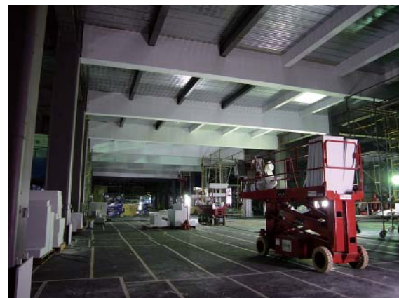
写真一3 内装工事状況
