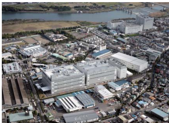
写真-1 完成写真
