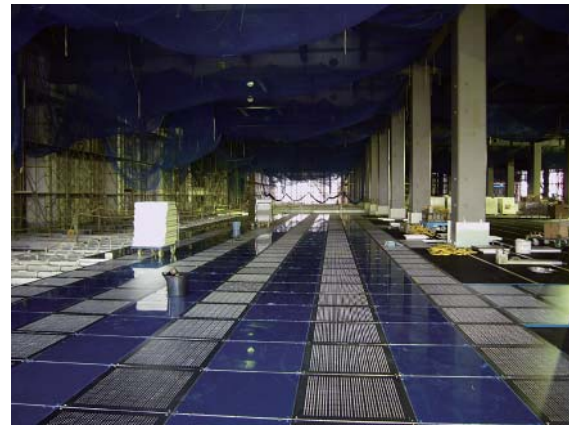
写真一2 床OA施工状況
