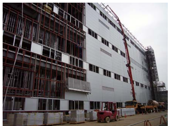
写真一4 外壁施工状況
