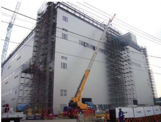
写真-7 揚重作業
