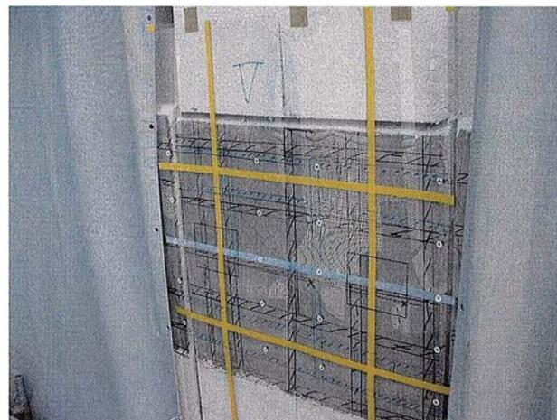
写真-9 あと施工アンカーの打設位置確認
