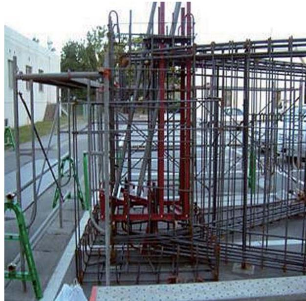
写真一4 基礎配筋原寸モックアップ (実物大)
