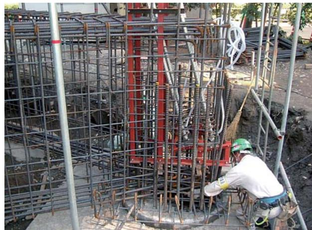
写真一5 アンカーフレーム施工状況
