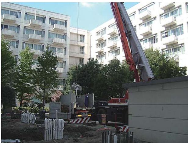
写真一3 レッカーによる杭頭余盛撤出
