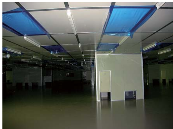
写真-1 FFU 設置，養生状況
