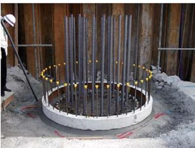
写真一八 引張定着筋挿入
