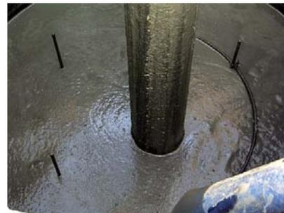
写真一3 コンクリート打設
