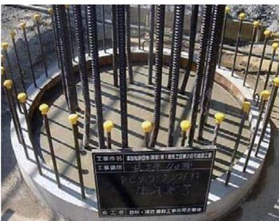
写真一九 杭頭モルタル打設
