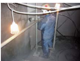
写真-9 JSS 工法
