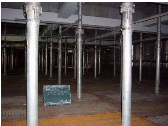
写真-4 4階支保工設置状況
