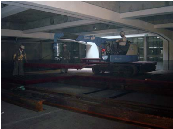
写真-2 構台組立状況
