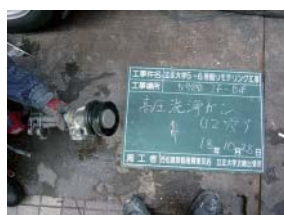
写真-10 多穴ノズル
