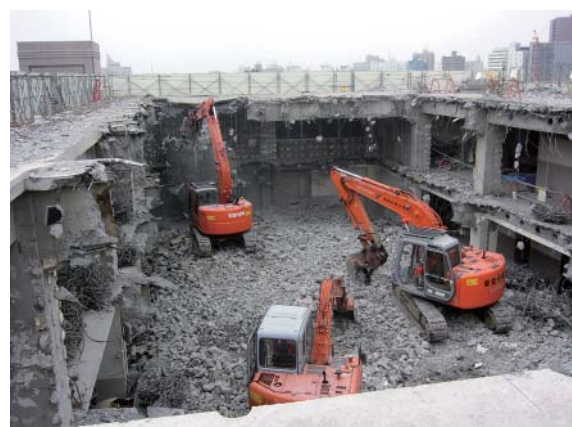
写真-6 解体用重機の稼働状況
