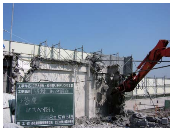
写真-5 倒壊防止用ワイヤー設置状況
