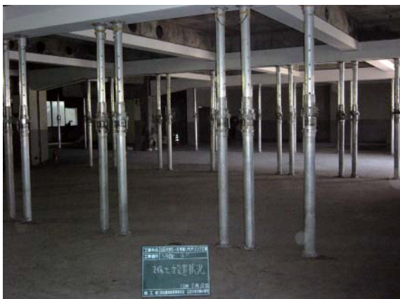
写真-3 3階支保工設置状況 (水平繋ぎ設置前)
