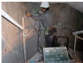
写真-7 ニュー・クイック工法施工状況
