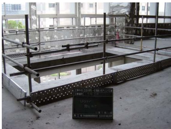
写真-1 5階投入口設置状況
