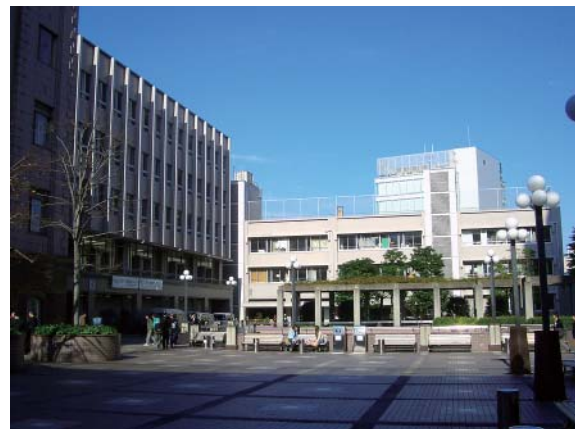
写真-11 改修前全景
