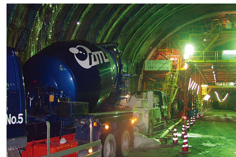
写真一9 覆工コンクリート打設状況 (西側坑口 T)
