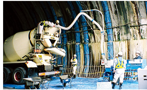
写真一8 アジテータ車への繊維投入状況 (実機試験)
