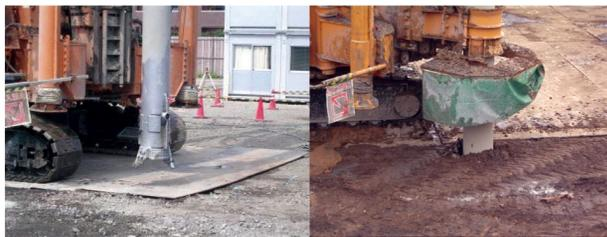
写真-1 ケーシングセット 写真-2 ケーシング貫入
