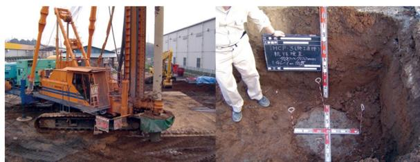
写真-5 ウェーブ施工 写真-6 施工直後の固化杭
