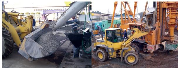
写真-3 コンクリート搬入 写真-4 コンクリート投入
