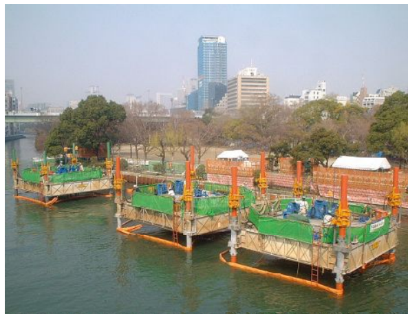
写真-1 河川防護工全景
