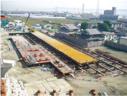
写真一三 東調整池施工状況
