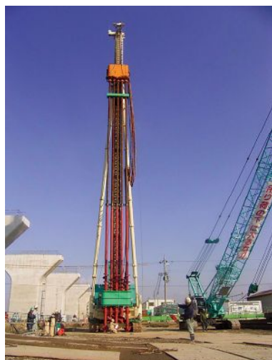
写真-2 ECW工法施工状況
