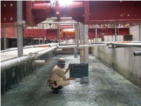
写真一四 アイランド工法施工状況
