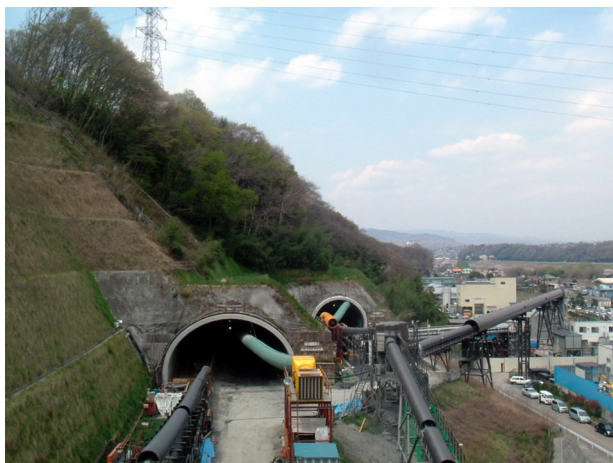
写真-1 坑口部全景
