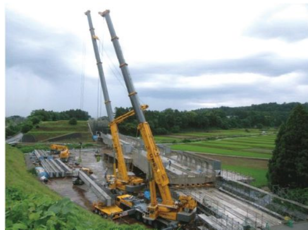
写真一5 Ctp8 主桁の架設状況
