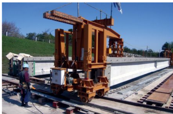
写真-1 電動 PC 桁横取り装置による施工
