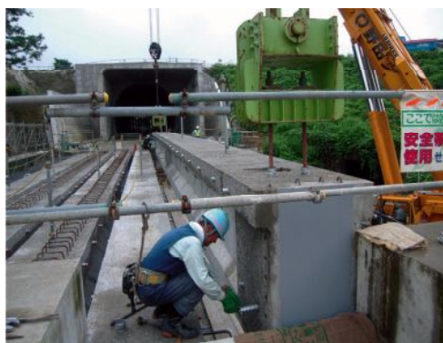
写真-3 機械式継手採用による施工 (Ctp8)
