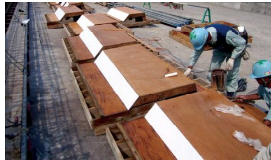
写真-2 表面特殊加工型枠、打継目処理剤塗布
