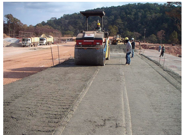
写真-2 一次試験施工 (締固め状況)
