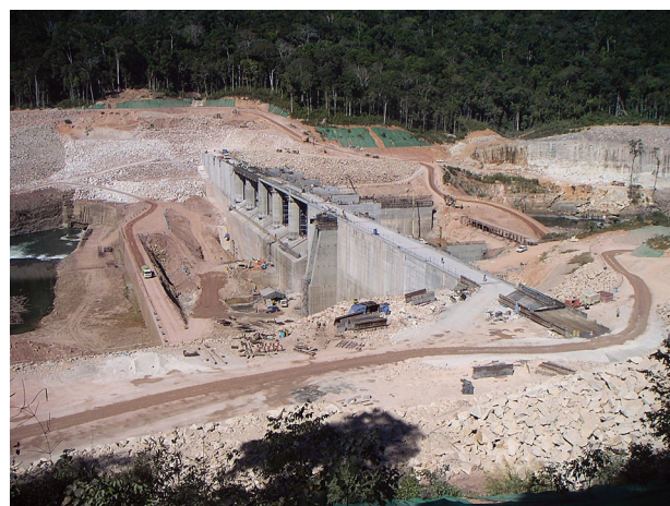
写真一1 ナカイダム全景（右岸上流より望む）
