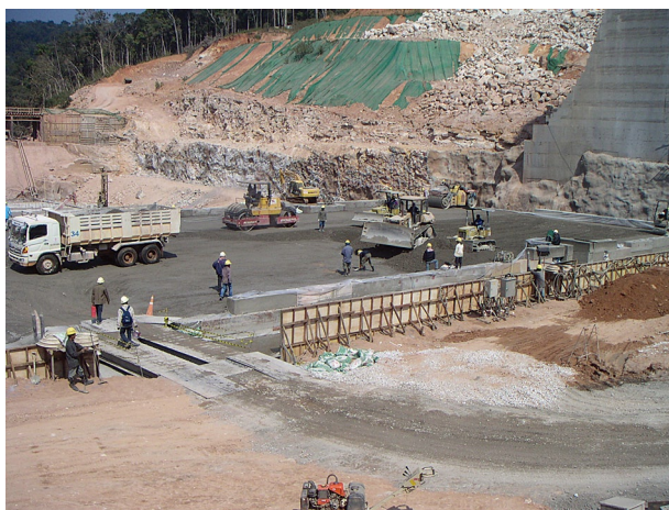
写真一3 堤体河床部打設状況
