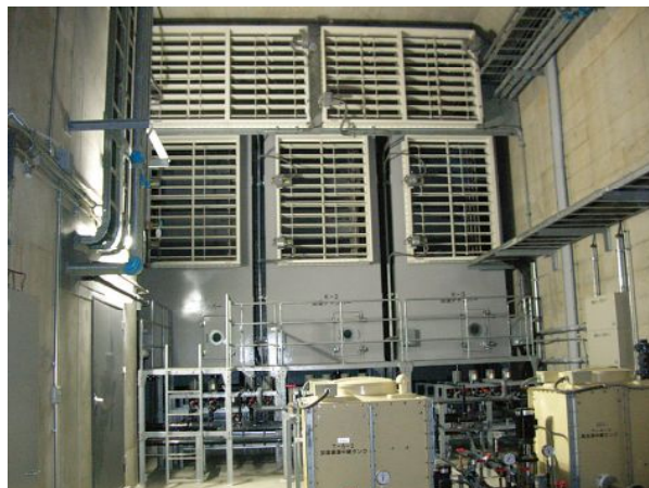
写真-1 脱硝装置の設置状況
