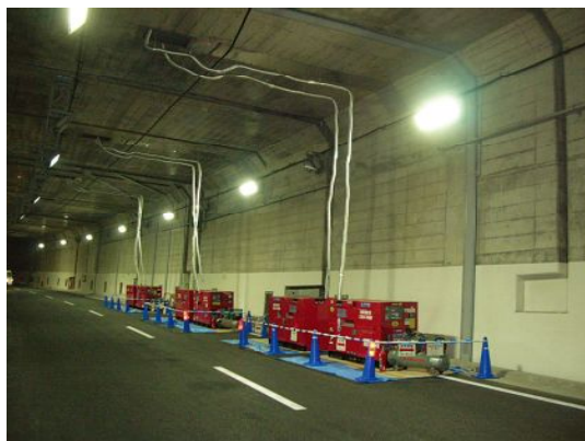
写真一4 性能試験排ガス用の発電機設置状況
