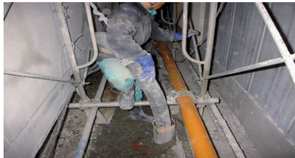
図-9 打設管より打設状況
