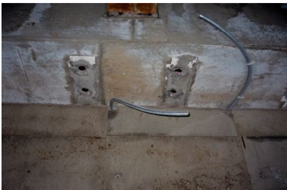
図-13 グラウト注入ホース (注入前)
