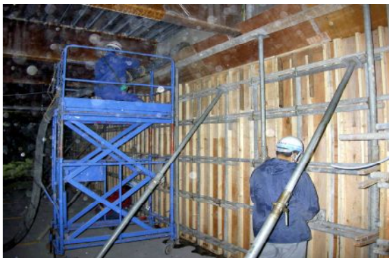
図-11 型枠じょうごより打設状況
