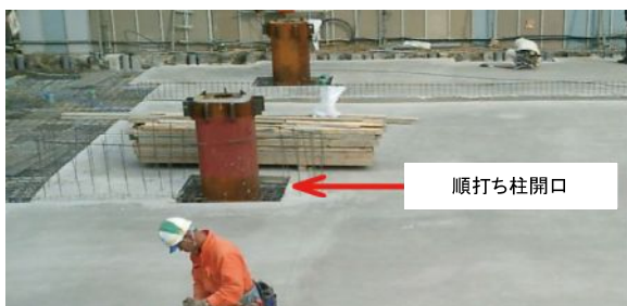
図-7 準打ち柱開口
