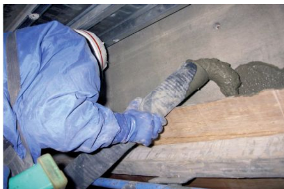
図-10 型枠じょうごより打設状況
