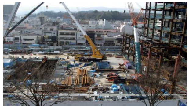
図-16 鉄骨建て方状況
