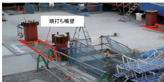
図-6 準打ち帳壁開口
