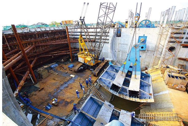
写真-3 ラジアルゲート設置状況
