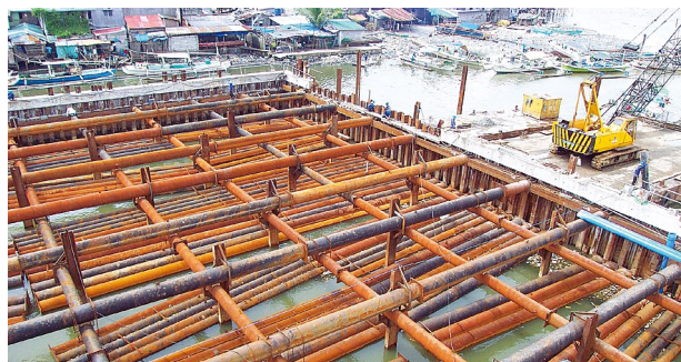
写真-1 1 段目切梁架設中状況
