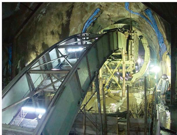
写真一1 移動式型枠
